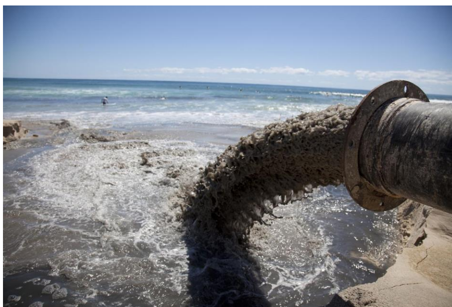
Figure 11 : Rejet d'effluents industriels sur la plage (©Ennesys)
