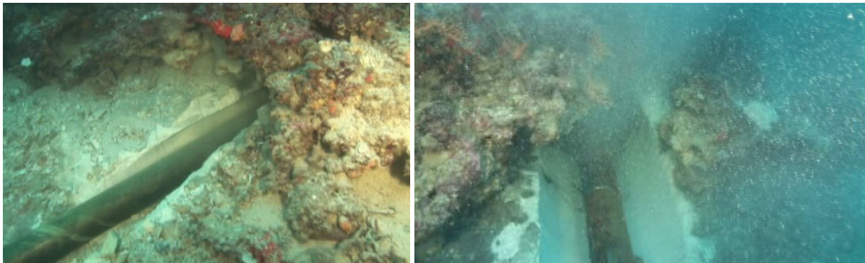
Figure 4 : [1] Perforage de la roche sur 100 mètres de long ; [2] Broyage par un aléser (Images sous-marines extraites d'un film réalisé par POISSON-LUNE Productions pour la communauté Nice Côte d'Azur).
