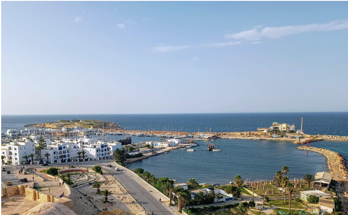
Figure 10: vue réelle du port et de l'avant-port marina cap Monastir
