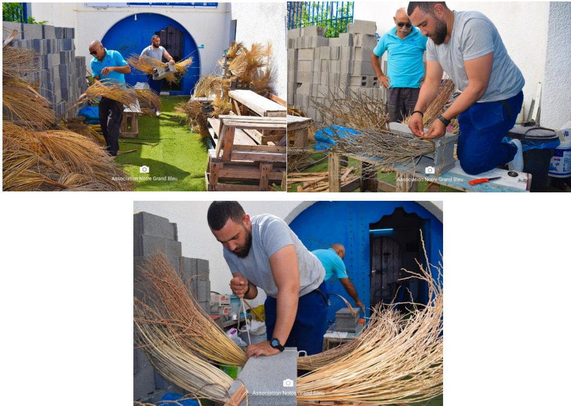
Figure 13: Assemblage des récifs de grappes de palmiers (©NGB)
