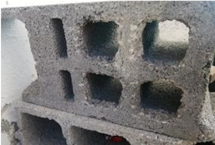
Figure 12: Forme du bloc en béton(©NGB)
