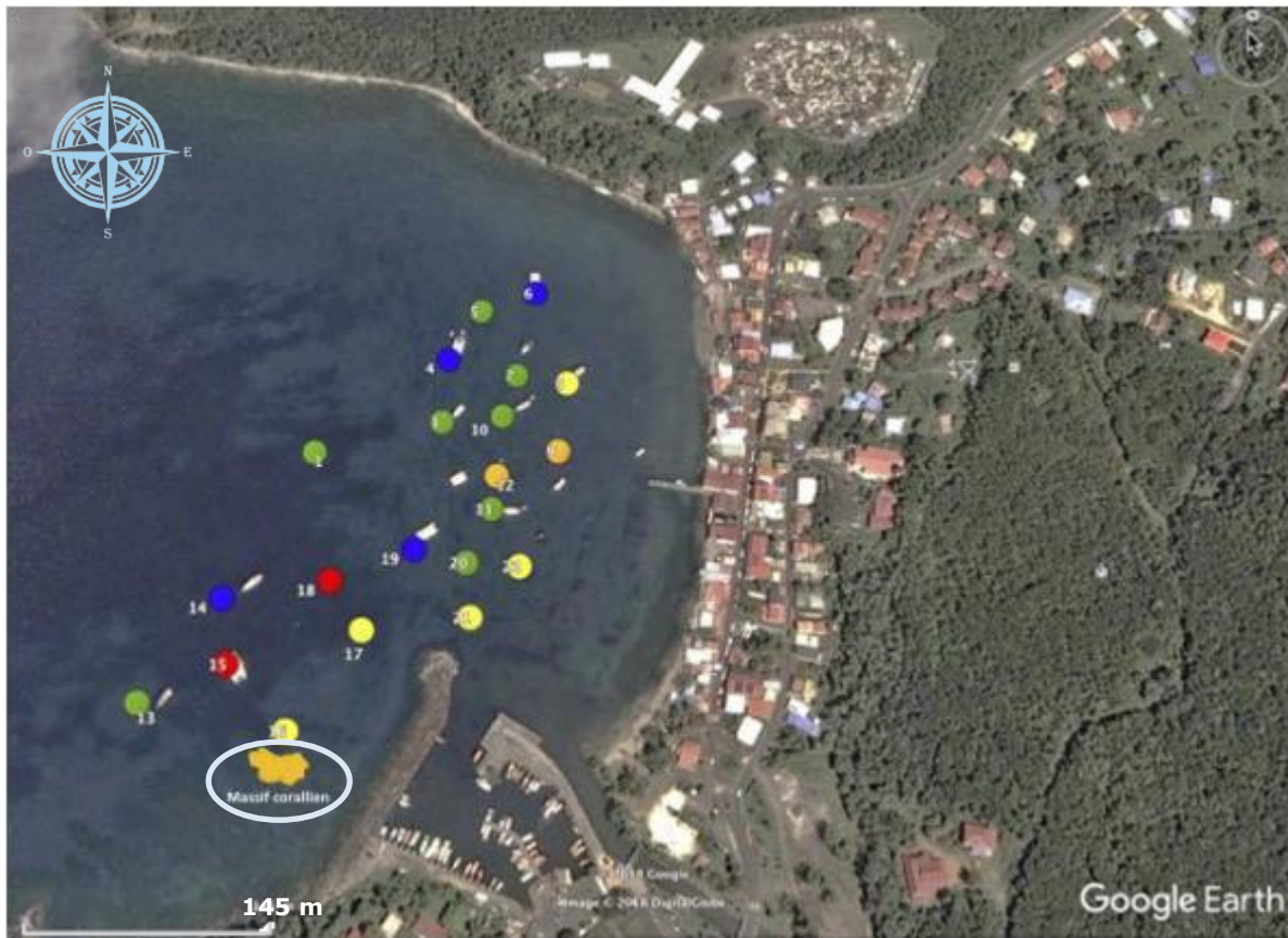
Figure 20 : Localisation des corps morts et du massif corallien de la baie de Deshaies (jaune : bloc mono-plateau ; orange : bloc double-plateau ; rouge : bloc avec grille en fer à béton ; vert : bloc mono-plateau avec ceinture de tubes ; bleu : bloc double-plateau avec ceinture de tubes) [7]
